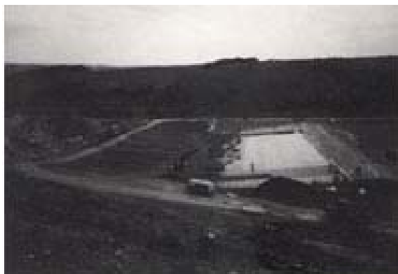
Abb 3.: Planlage der Kunststoffdichtungsbahnen beim Aufbau der Endriegel
