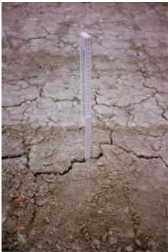
Abb. 4: Unzulässige mineralische Dichtungsoberfläche mit Trockenrissen
