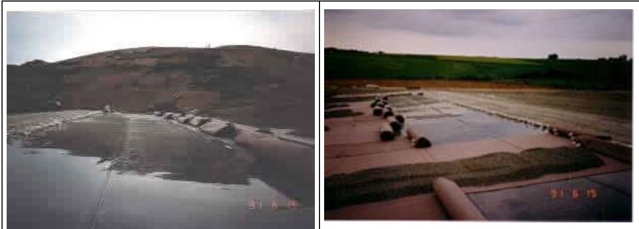
Abb. 1 und 2: Planliegende Kunststoff-Dichtungsbahnen vor dem Schutzschicht- und Flächenfiltereinbau
